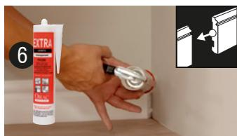
**Use DecoFix Extra in every joint** | Gebruik DecoFix Extra in elke naad | Utilisez DecoFix Extra pour chaque joint | Verwenden Sie DecoFix Extra bei jeder Naht | Utilice DecoFix Extra en todas las juntas
